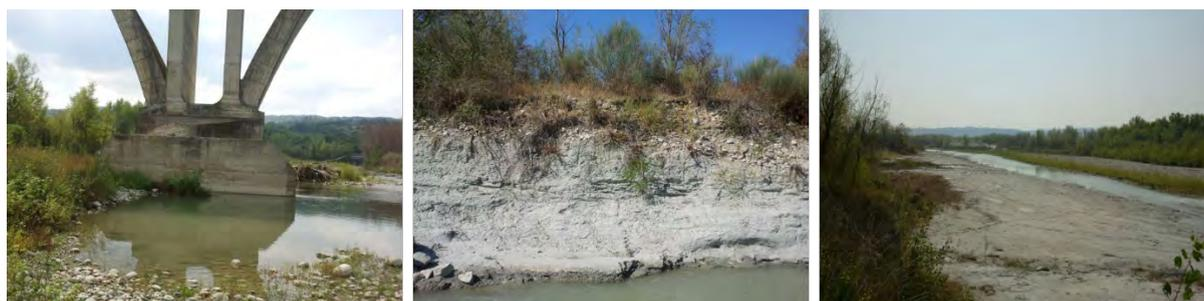
Figura 2: Evidenze di campagna del processo di incisione dell'alveo. A sinistra – sottofondazione del ponte della ferrovia Roma-Firenze (alta velocità); a destra e al centro – affioramento delle argille marine plioceniche (substrato) sulla sponda e sul fondo alveo.
